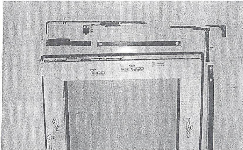
Kammergetriebe mit Steckgriff und Schließzapfen werden wieder eingesetzt!
