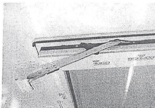
Riegelstange (4) bei Eckumlenkung, kurz, an den "Clipsfüßen" auf 70 mm Länge um 1 mm kürzen (abfeilen).
